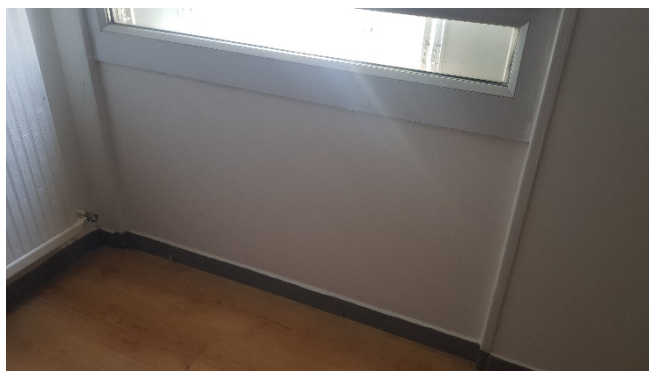
Panneau sandwich en fibrociment en allège de la fenêtre – Chambre 2
