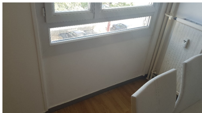
Panneau sandwich en fibrociment en allège de la fenêtre – Chambre 1
